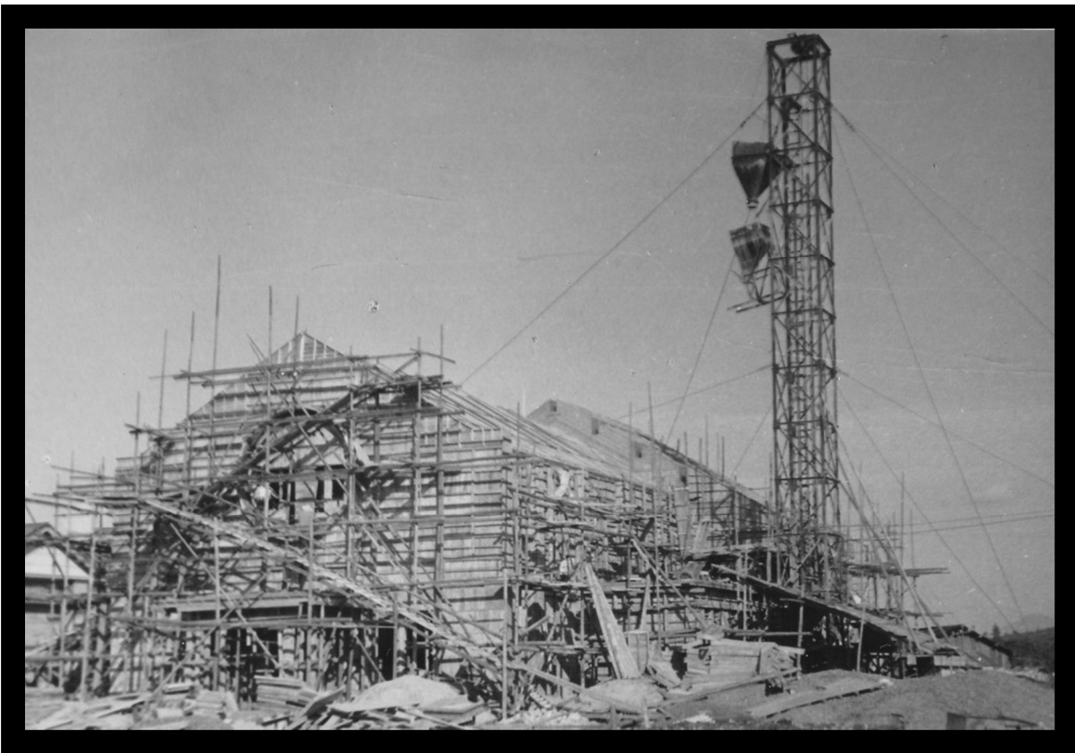
I7:3.4 Construction de la chapelle du Grand Séminaire de Fukuoka, en 1952 ou 1953.
