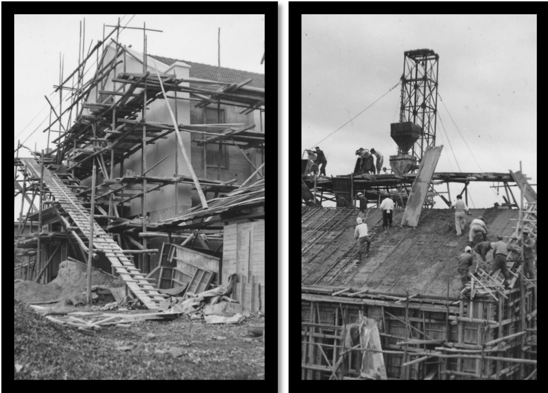
17:3.4 La chapelle du Grand Séminaire de Fukuoka en construction pendant les années 1952 et 1953. À gauche, la façade, à droite, le toit.
