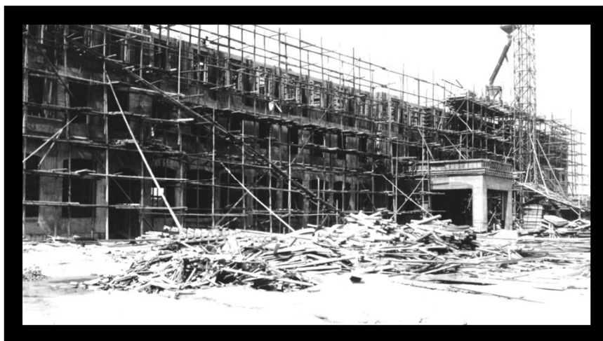
I7:3.4 Construction du Grand Séminaire de Fukuoka, en 1950 ou 1951. On y voit la façade et l'entrée.
