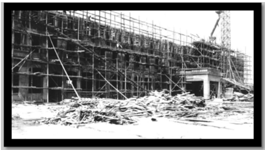
Construction du Grand Séminaire de Fukuoka en 1950 ou 1951. I7:4-1
